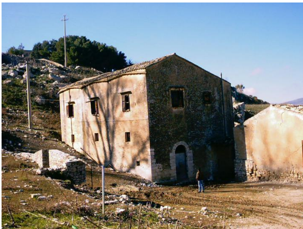
Fabbricato rurale di portella della Ginestra prima dell'intervento di ristrutturazione
